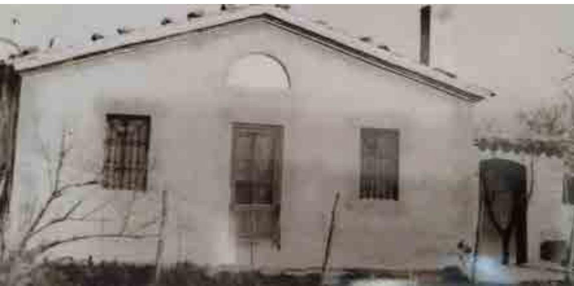
Façana de la casilla de Mafet quan hi vivia la família Villuendas. Avui està totalment enderrocada.
