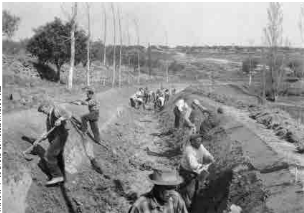
Treballadors refent manualment el caixer del canal. Any 1960.
