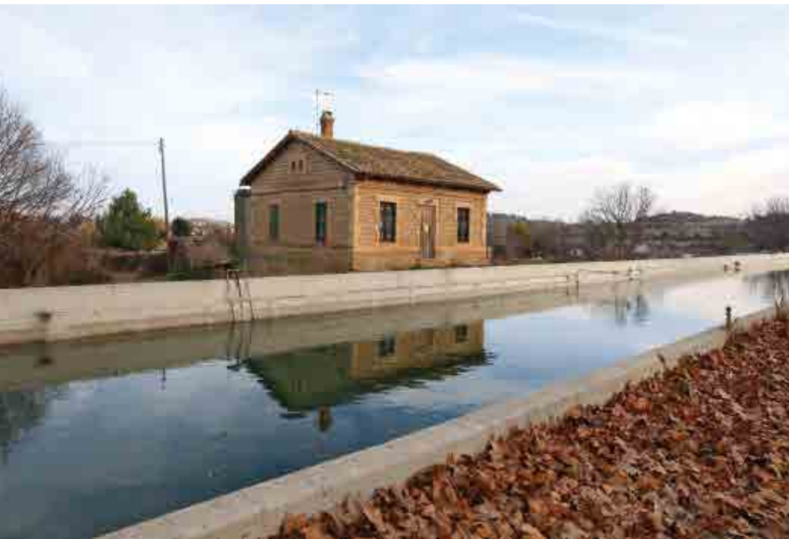
Vista actual de la casilla del pont de Ferro.
