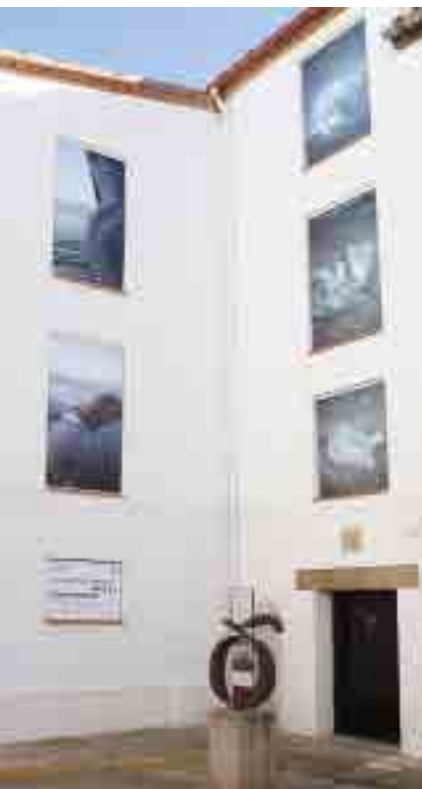
Instal·lació fotogràfica a la façana de Lo Pardal.
