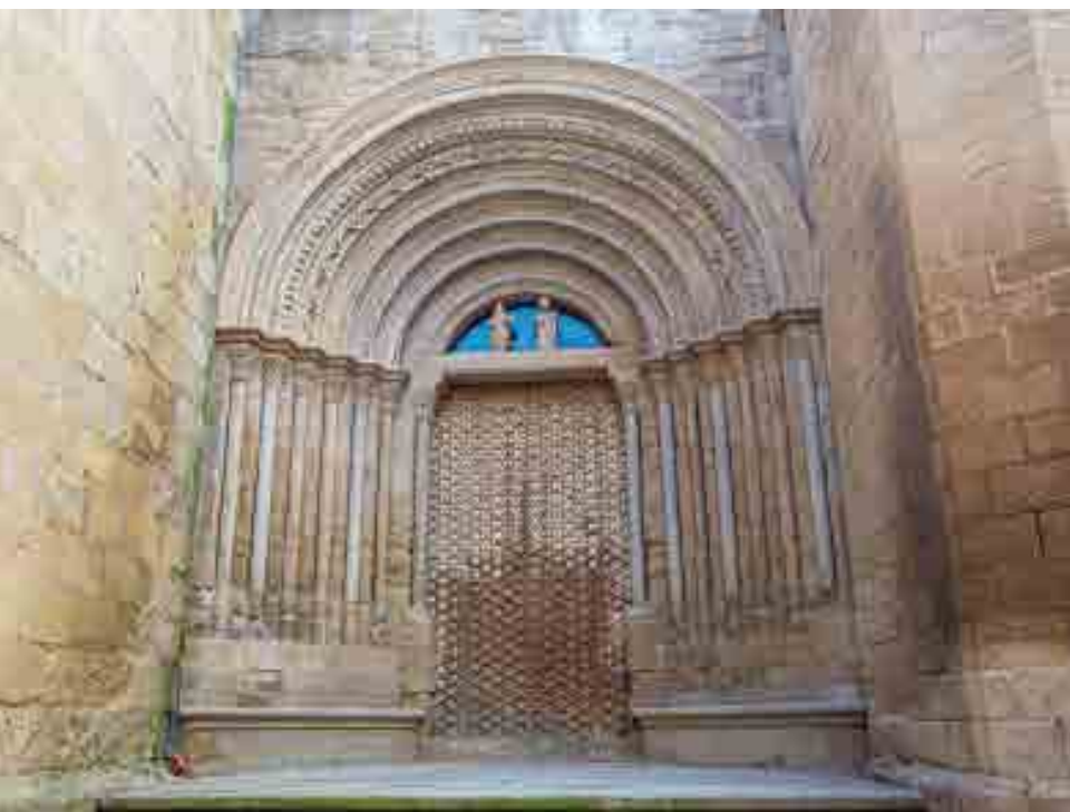
Portalada nord de l'església restaurada recentment.
