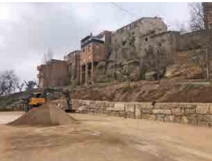
Mur d'escullera de pedra a Butsènit.
