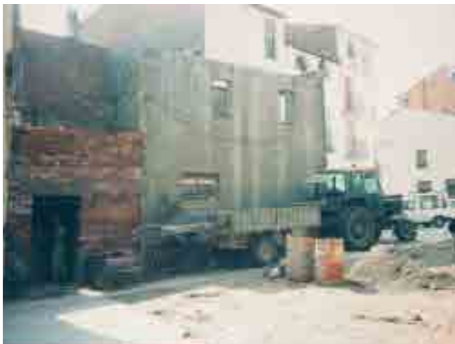
Començament de les obres de Lo Pardal 3.
