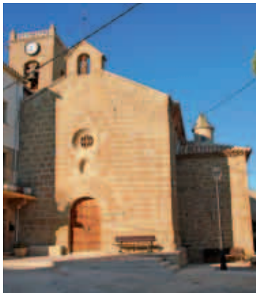
Església de Sant Llorenç amb les obres a punt d'acabar.
