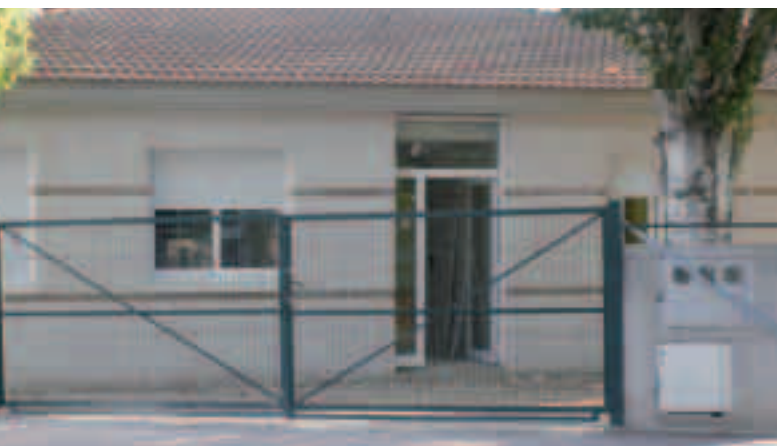
La porta d'accés a la llar d'infants hauria de ser objecte d'una modificació perquè amb l'estat en què està actualment no compleix les normes de seguretat.
