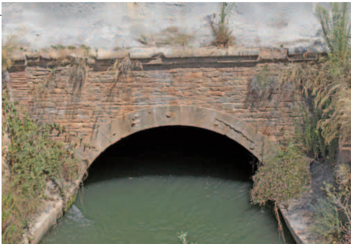
Boca sud del Túnel.
