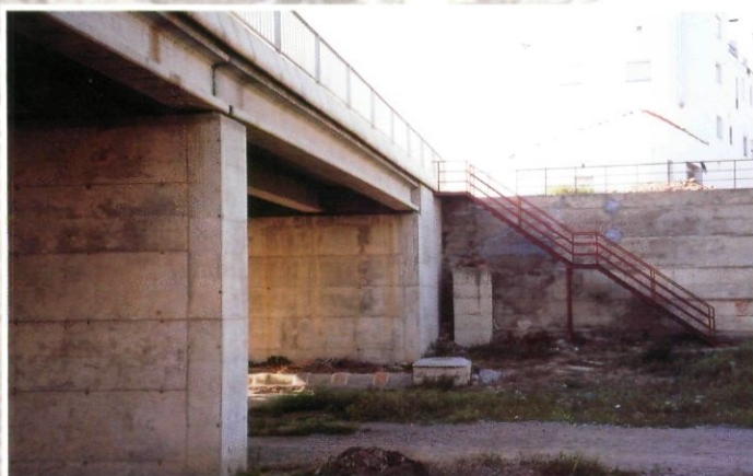
El viaducte de la carretera de Tàrraga és més nou, ja que ha estat reconstruït amb les recents obres de millora de la carretera.
