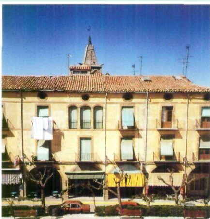
La plaça del Mercadal ja llueix el nou disseny després de les obres de rehabilitació.
