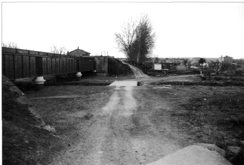
Substitució del pont sobre el riu Sió al costat del Pont de Ferro.
