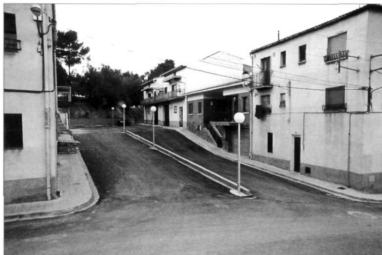
Urbanització C. Convent, zona dels Dipòsits.
