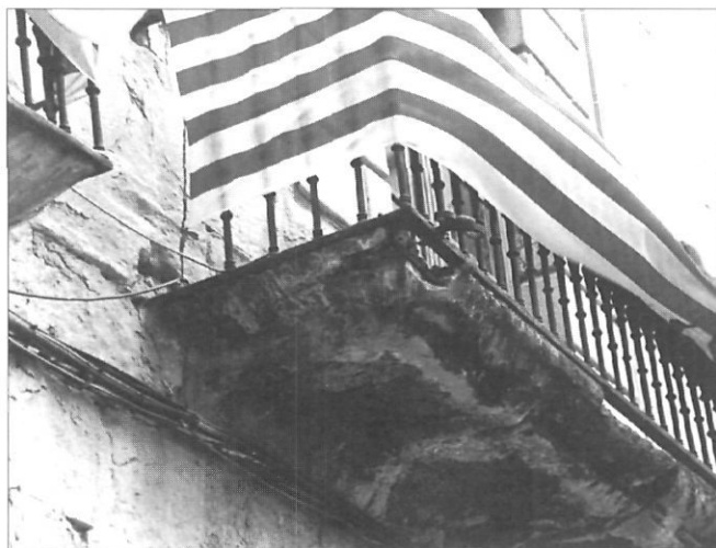
L'actual façana de l'Ajuntament que dóna a la plaça necessita un adequat agençament.
