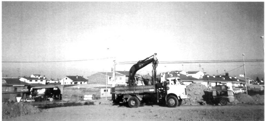
Construcció de la rasa a l'entrada a la nostra vila.
