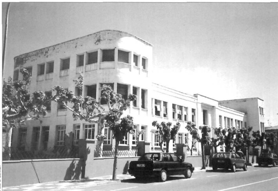
Grup escolar Macià-Companys. Edifici vell.
