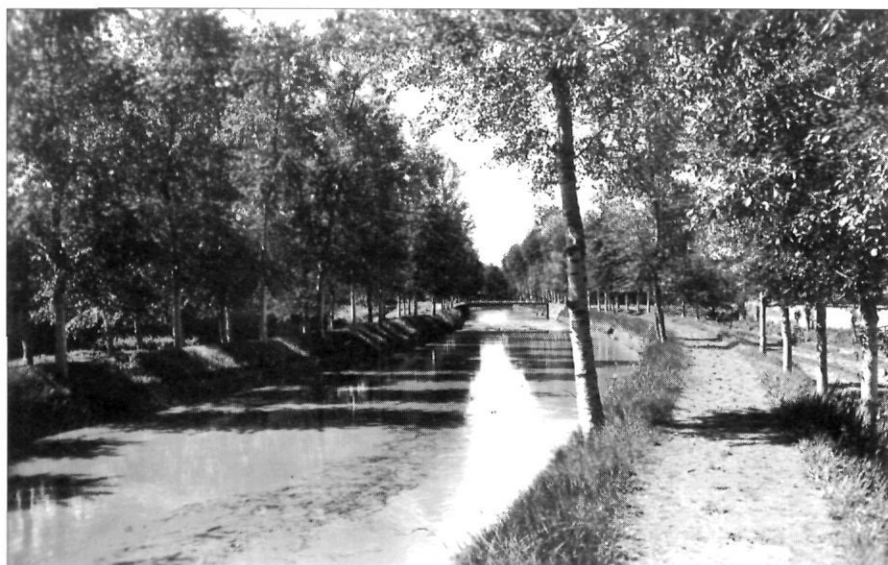
El Canal, abans de la pavimentació, a continuació del Pont de Ferro.
