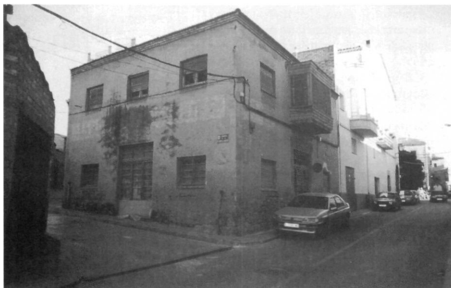
Edifici on durant molts anys van tenir instal·lat el taller. A la paret encara s'hi pot llegir –molt dèbilment– "Fusteria Serés" que era el nom de l'anterior propietari.
