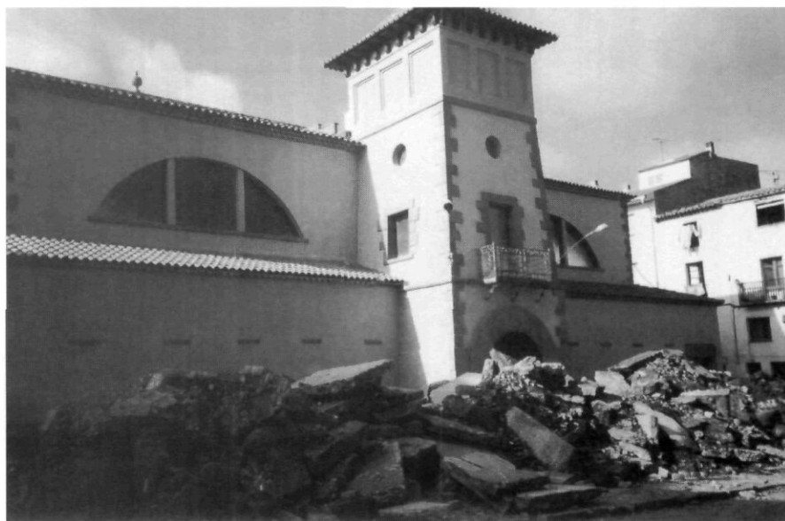
Amb les obres s'ha alçat tota la plaça.
