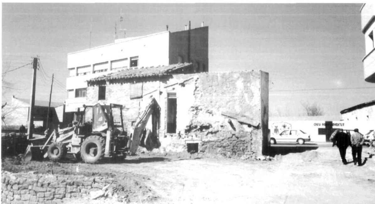
Les màquines enderroquen els vells edificis.
