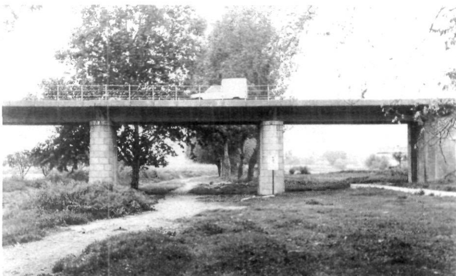
Pont a la carretera de Tàrrega que serà enderrocat.
