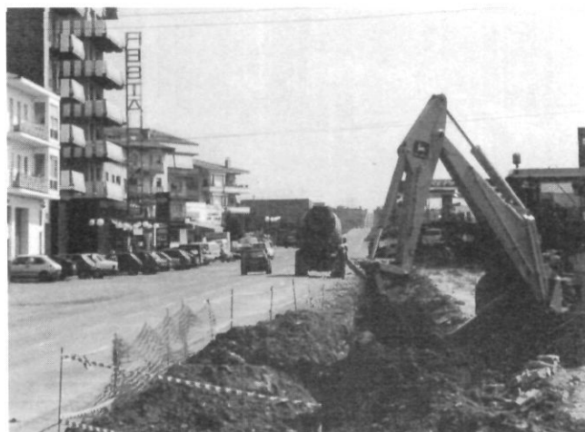
Obres a la travessia de la carretera de Tàrraga-Artesa.
