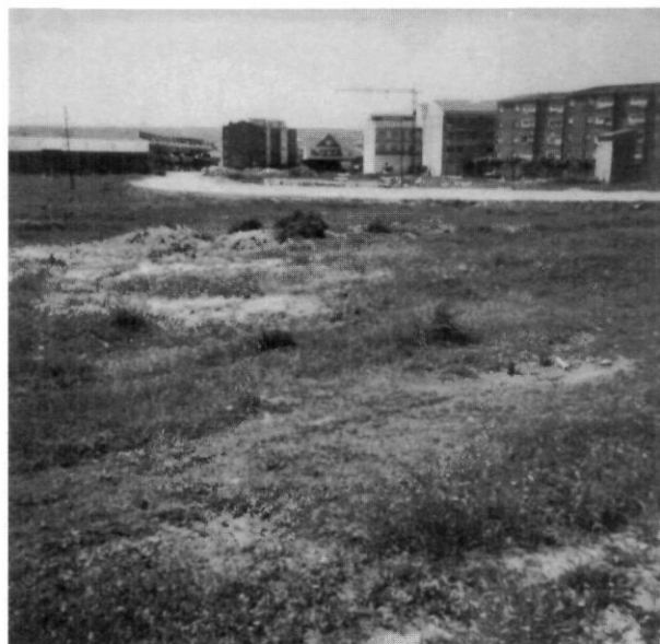
Les obres d'urbanització de la Ronda Molinal s'hauran d'iniciar en breu.
