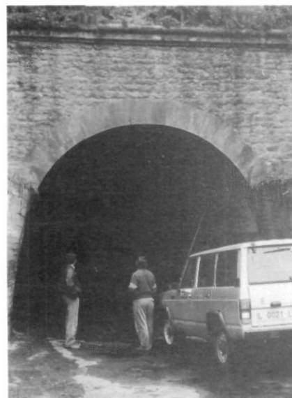
El túnel de Montclar, l'obra més difícil de la construcció del Canal.
