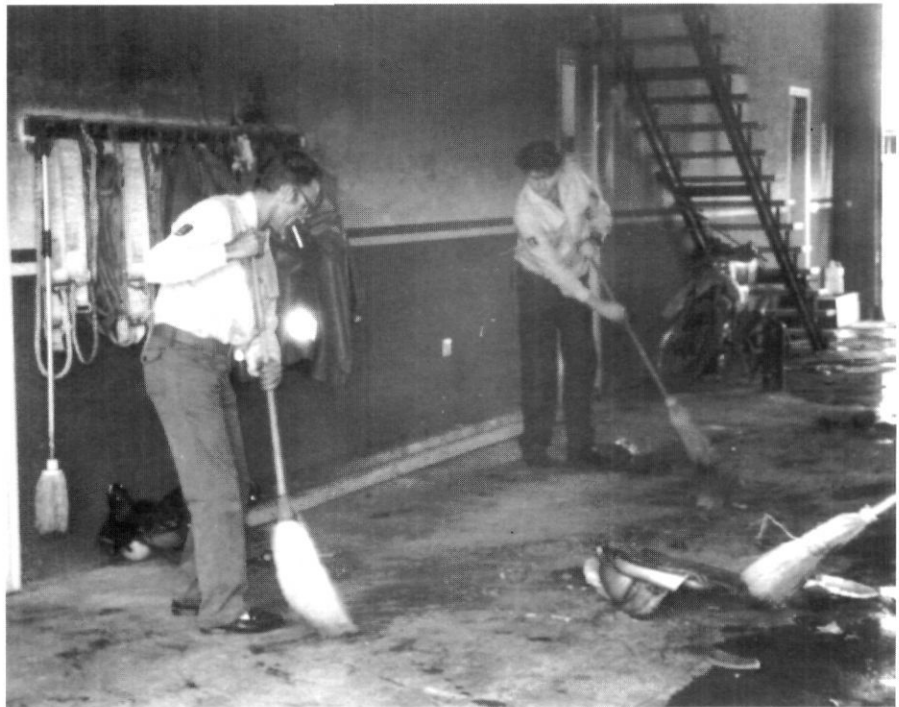
El foc afectà el sostre del Parc.
