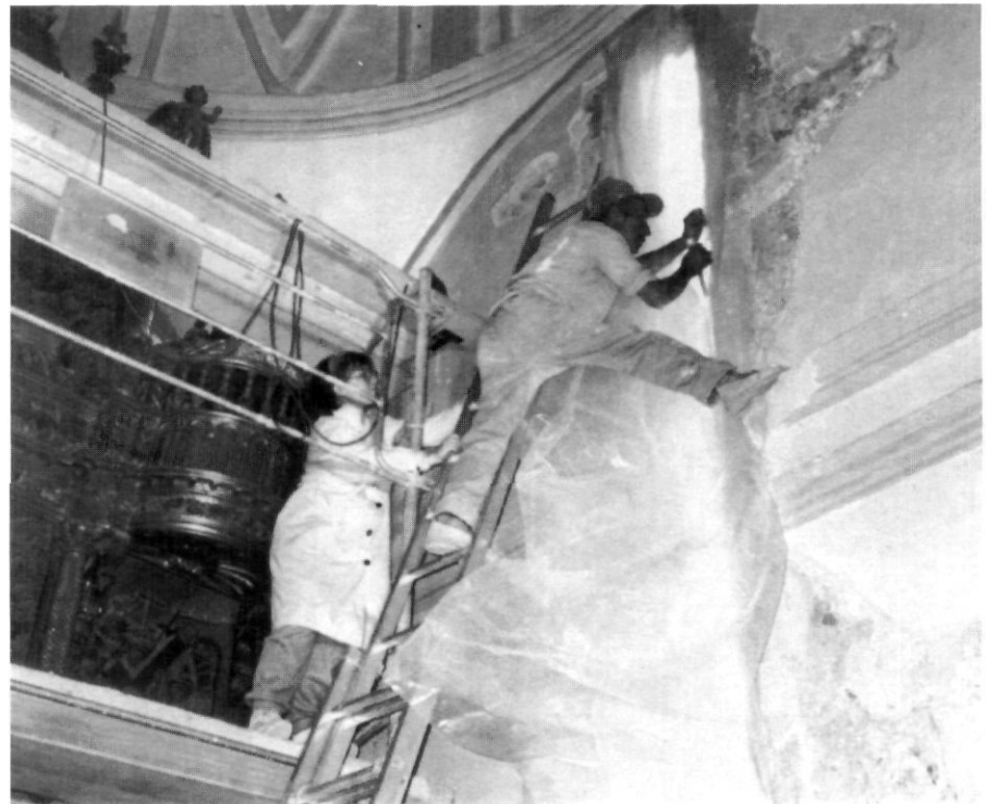
Una fase de les obres.
