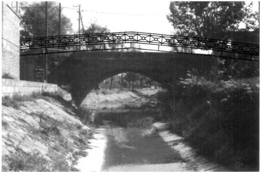
Vista lateral de la passarel·la per a vianants.
