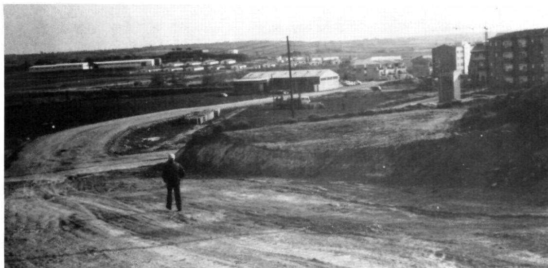
Panoràmica de l'obertura d'un nou carrer que unirà la carretera de Cervera amb els actuals ravals.
