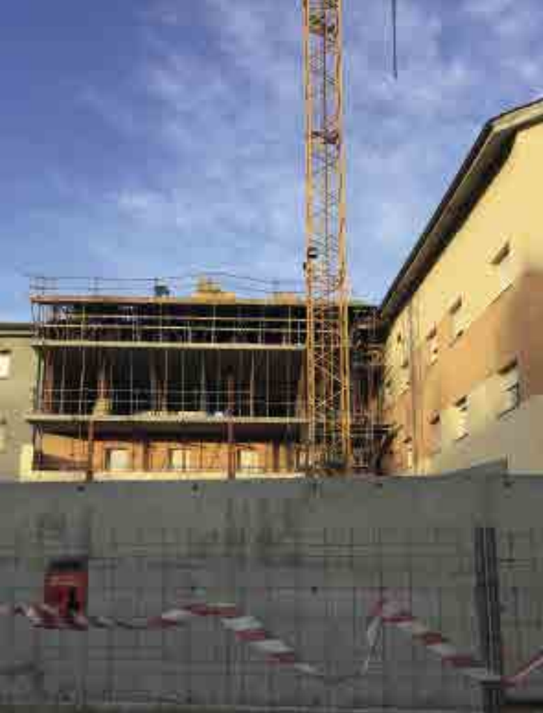
Detall de les obres de remodelació de la residència, vista des del Passeig.
