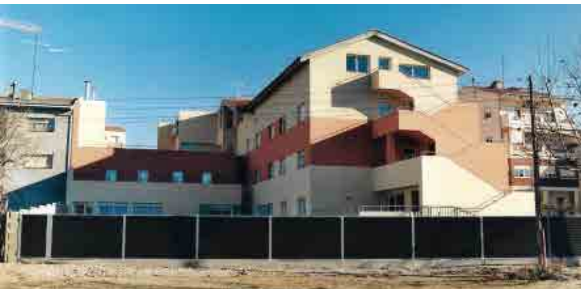
Vista de l'edifici des del Passeig.
