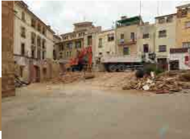
Els treballs de desenrunament s'han fet amb una gran pala excavadora.
