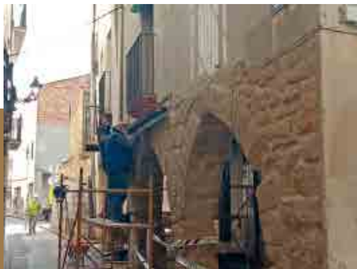
Abans de tirar a terra les cases les dues arcades del porxo de Cal Vidrié s'han apuntalat provisionalment.
