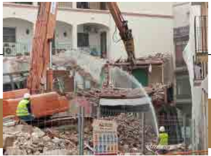
Per evitar la pols un dels treballadors ruixava l'obra amb una mànega.
