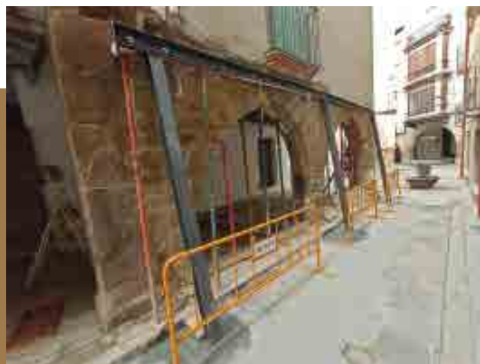
Abans de tirar a terra les cases les dues arcades del porxo de Cal Vidrié s'han apuntalat provisionalment.
