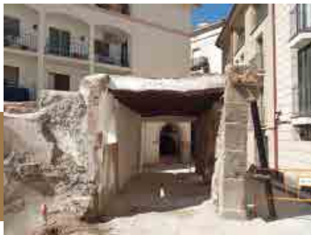
Durant l'enderroc s'ha deixat la part de la façana interior del porxo per tal de donar estabilitat al conjunt.
