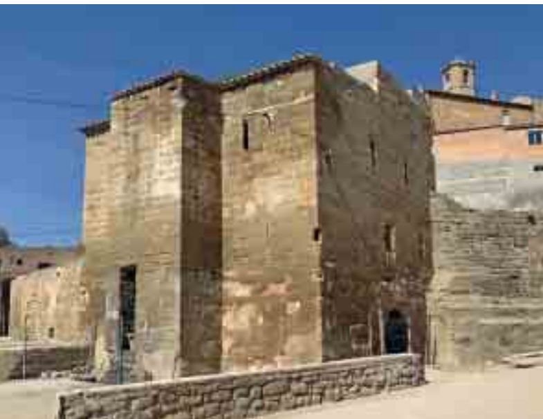
Façana de migdia de l'edifici fortificat del molí amb l'espectacular contrafort.
