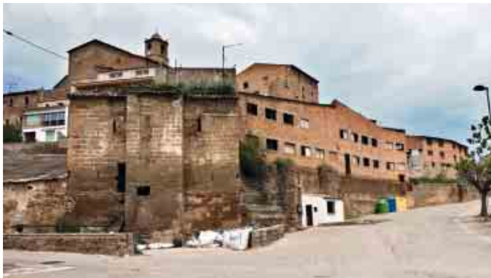
Edifici medieval de molí fariner amb la seva estructura fortificada. A la dreta, la bassa de l'aigua del molí amb quatre contraforts per contrarestar la pressió de la mateixa, amb la bàscula municipal construïda en mig dels dos primers contraforts i la granja de dos pisos situada al damunt de la bassa. A l'esquerra, l'edifici cobert amb peces d'uralita era l'antic molí d'oli.
