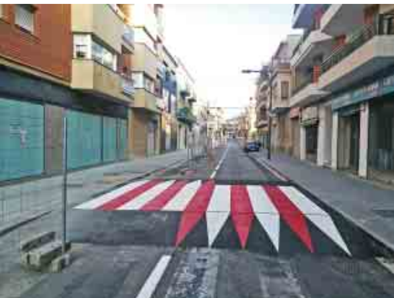
Obres carrer Jaume Mestres.
