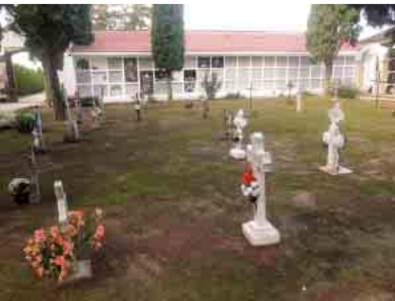
La galeria de Ntra. Sra. del Carme, una de les més antigues del cementiri, va haver de ser reconstruïda per deficiències estructurals.
