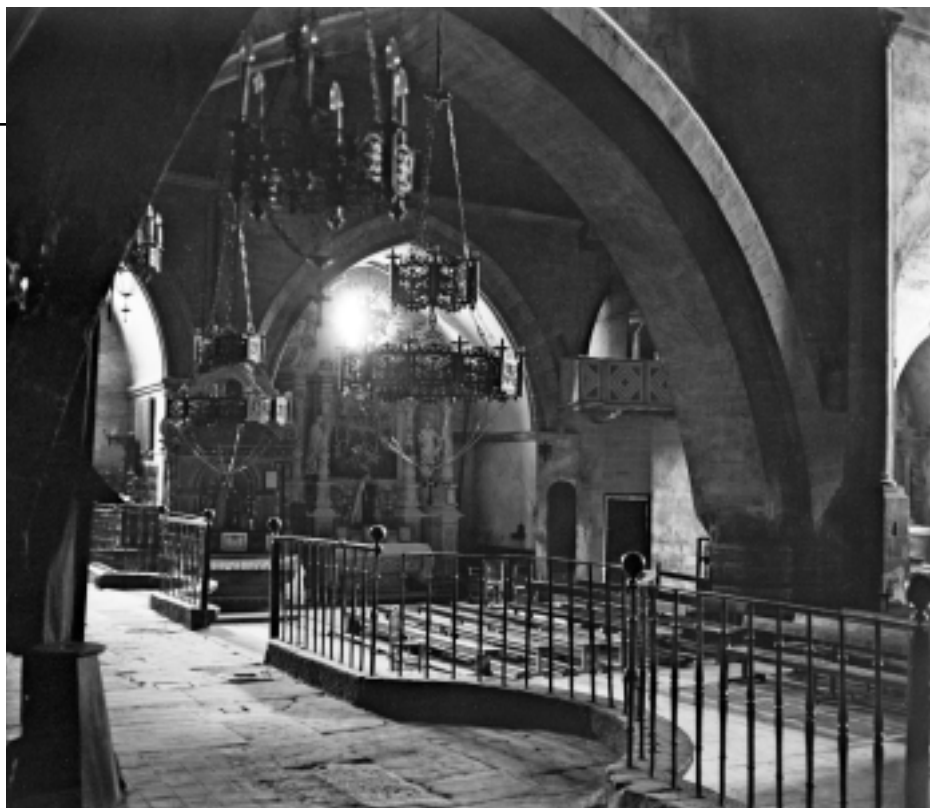
Imatge interior de l'església abans de la restauració de 1952, amb el presbiteri molt més gran que en l'actualitat. Al fons, el mur de migdia amb la balconada de l'orgue a sobre de la porta d'entrada i dues capelles obertes al mur que després es van suprimir.
