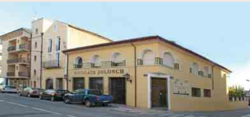
Façana de l'edifici que fa cantonada amb el carrer Santa Esperança.
