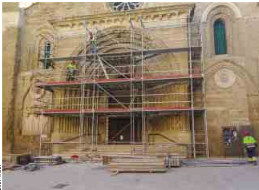
Bastides a la portalada principal per restaurar-la i consolidar-la.
