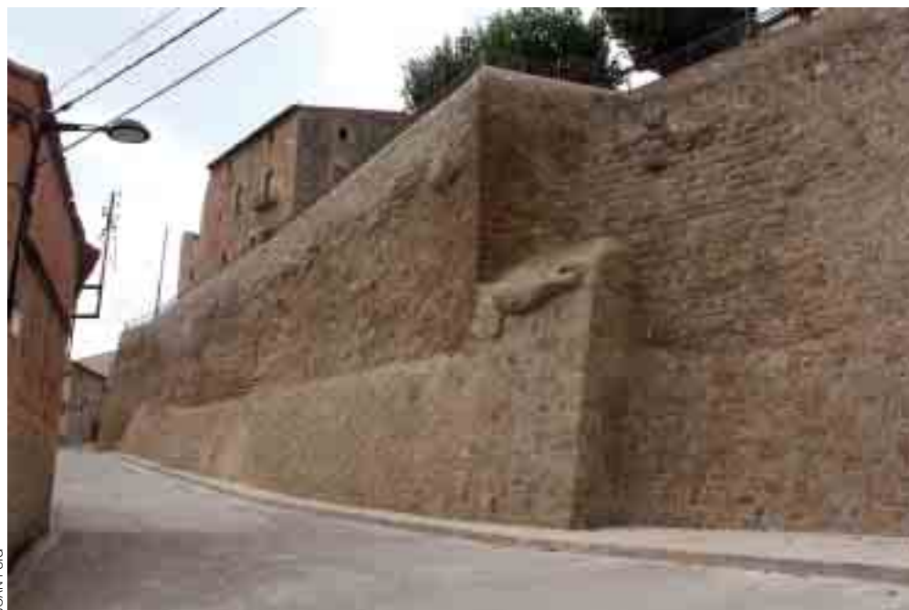
Talussos de muralla consolidada, recuperada i restaurada.
