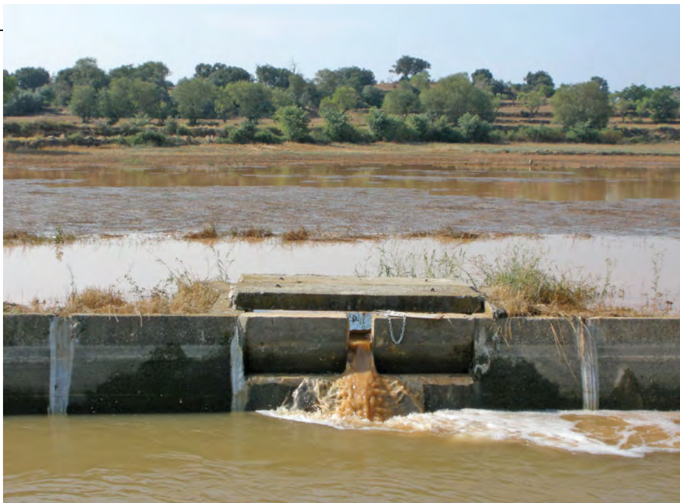
Al canal d'Urgell es va instal·lar un estellador per canalitzar l'aigua entollada. L'aiguat és de l'any 2008.
