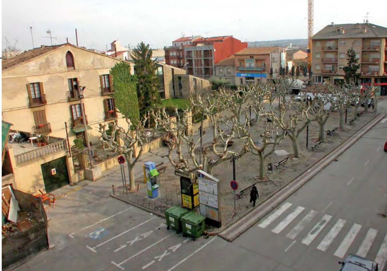
Les obres d'ampliació van començar arrencant el vell paviment, mentre encara es manté en peu el pouet central.
