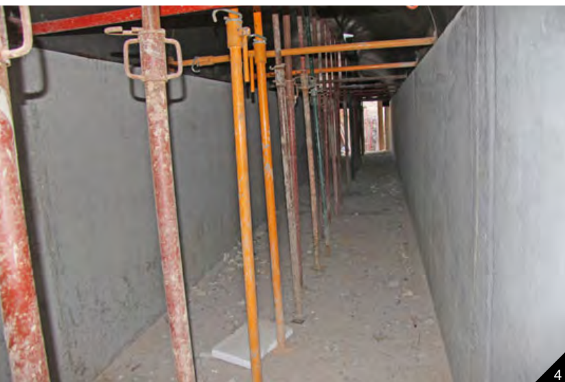
Vista interior de la construcció del túnel d'accés.
