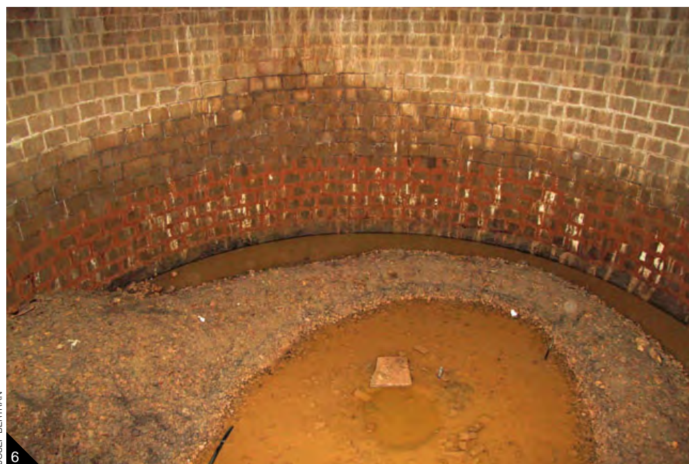
Interior de la cisterna amb la runa i les restes òssies.
