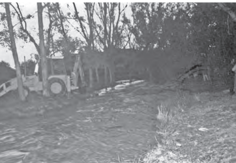
Les màquines van actuar per netejar la llera i retirar el pont del Passeig Nou.
