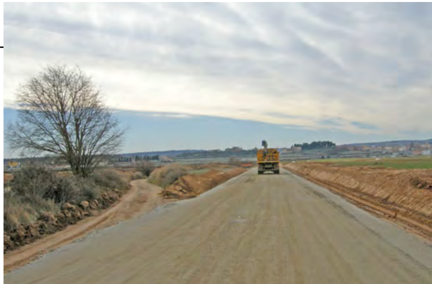
En aquesta foto es veuen els canvis experimentats en la xarxa de camins del terme. L'antic camí de Serrallonga, a l'esquerra, va ser substituït per una via ampla i recta. Amb tot, la feina no es va fer prou bé i circular-hi és problemàtic per les pedres soltes que omplen tota la superfície dels camins de la zona nord. Les intenses pluges del mes d'agost han malmès trams de camins i aquests nous camins han tallat el pas als antics desguassos naturals.
