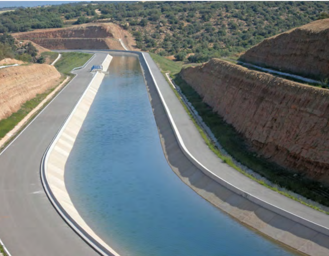
El canal totalment acabat passa per sota el nucli de Coscó després del túnel per travessar la serra de Maravella.
