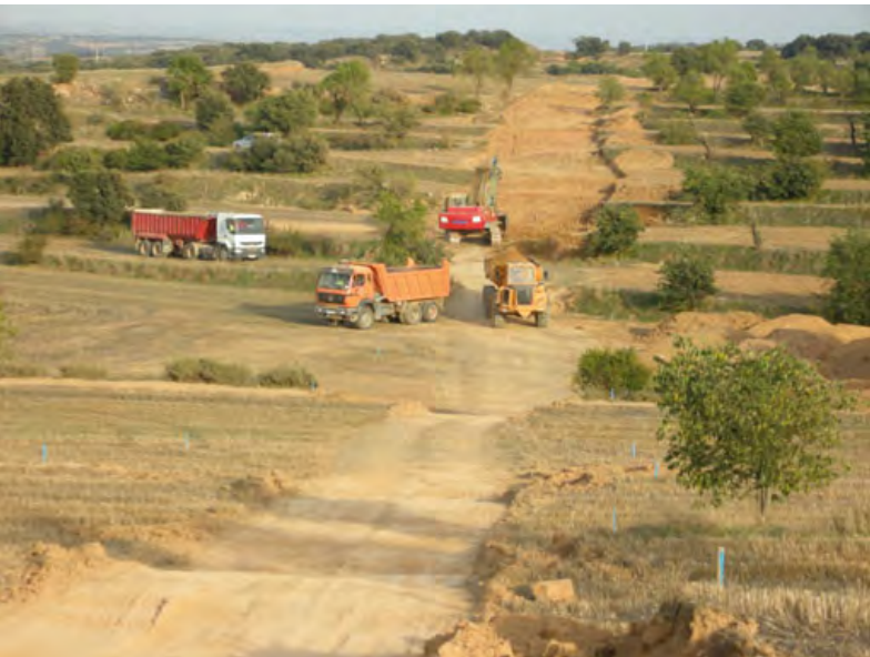
El mes de setembre del 2012 comencen les obres de la concentració parcel·laria del canal Segarra-Garrigues que afecten un total de 3.000 hectàrees. Durant mesos la nostra Vila va ser el centre operatiu de les empreses de maquinària pesada que van fer els treballs d'obrir camins, aplanar finques i posar les instal·lacions de reg.
