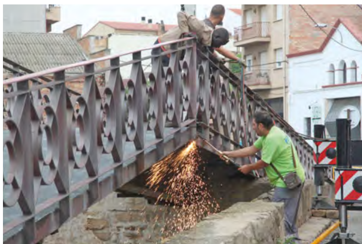
Després d'estar instal·lada durant 19 anys, l'agost del 2013 es retira la passarel·la metàl·lica del costat del pont Medieval. Una de les feines més laborioses va ser la de tallar les fixacions de l'estructura.
