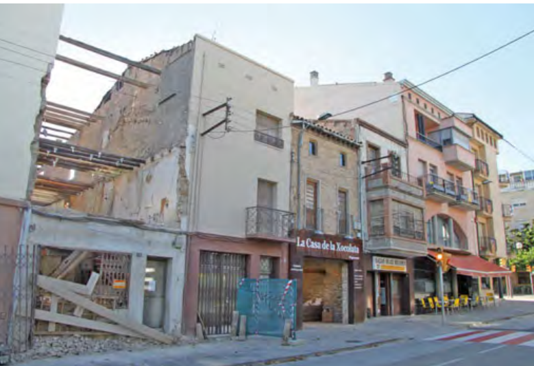
Acabades les obres de la nova vorera del Pou s'enderroca la casa número 12 que estava en malt estat i deshabitada des de feia temps. És un pas més en la rehabilitació i renovació dels immobles més antics de la plaça.
