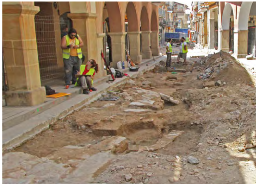
A començaments d'estiu del 2014 comencen les obres de rehabilitació del carrer Sió amb una previsió de nou mesos d'execució. També afecten una part de la plaça de l'Església i el primer tram del carrer Sant Joan. El projecte estava programat inicialment per al 2011, però el canvi de govern municipal va suposar l'endarreriment a conseqüència d'una nova política d'obres i serveis. Els treballs van començar amb unes prospeccions arqueològiques. Van sortir a la llum les antigues xarxes de clavegueram, cups i els fonaments d'alguns coberts desapareguts.
