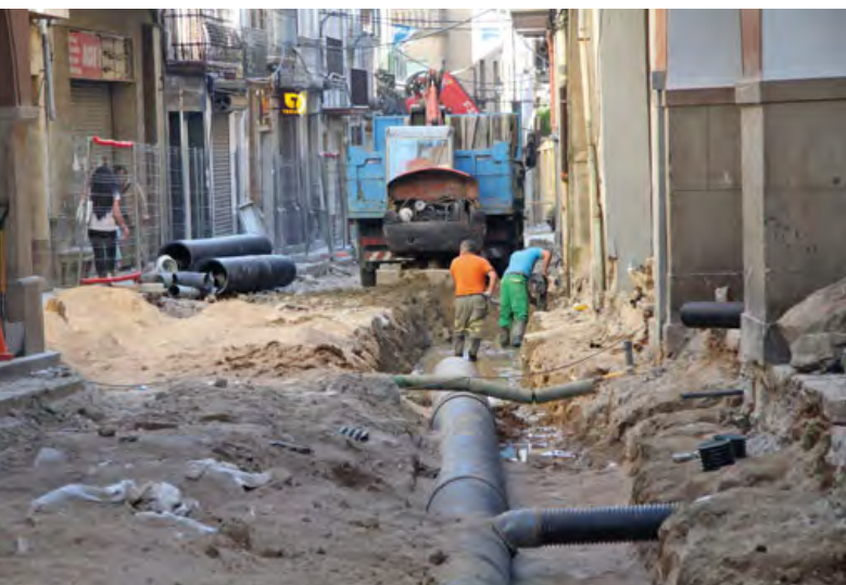
Una vegada documentades les troballes es procedí a la col·locació de la xarxa del nou sistema de clavegueres i servei d'aigua. Un sistema superdimensionat a la vista del diàmetre de les canonades.
