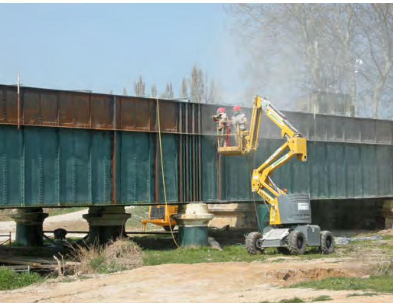
Les obres es van fer durant l'hivern del 2013 i primavera del 2014. A la foto els treballs finals de pintura.
