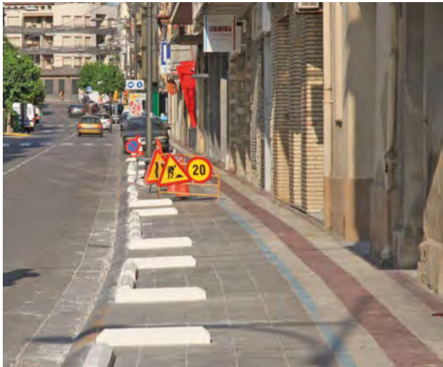
Una de les obres –petita obra–, més polèmiques va ser la instal·lació d'uns inusuals elements de formigó a la vorera de migdia de l'avinguda Marià Jolonch. L'objectiu era impedir físicament l'estacionament de vehicles per facilitar el pas de vianants. Davant la protesta d'una part dels veïns l'Ajuntament cedeix retirar els elements perpendiculars, pel perill dels vianants que pretén protegir. Amb tot, les denúncies d'aquesta instal·lació han continuat per les molèsties i accidents que provoca. A primers de setembre, però, es van començar a substituir les peces de formigó del tram on és permès aparcar, per uns pilons verticals flexibles.
