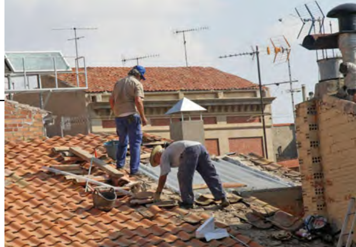
Durant mesos es van anar reparant i substituint milers de metres quadrats de cobertes afectades per la pedregada i altres elements com claraboies, persianes, canalons, etcètera.
