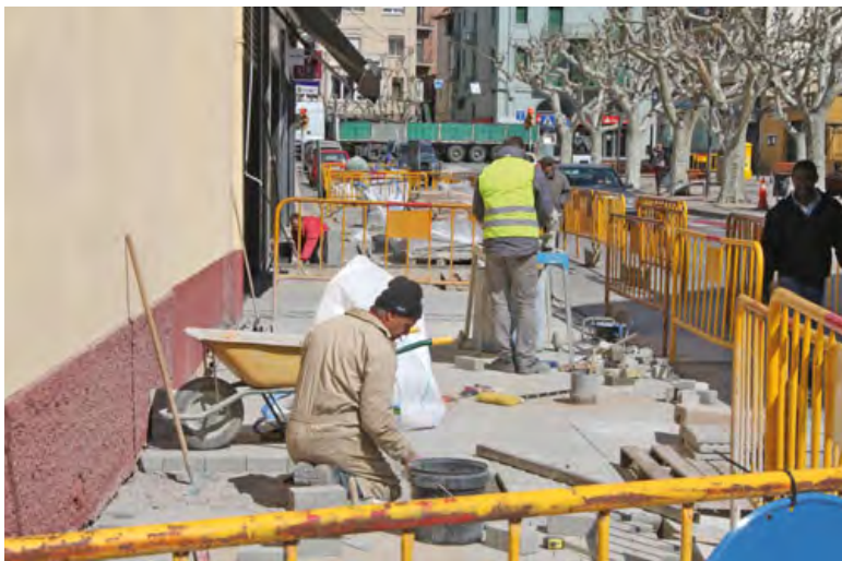
Durant la primavera del 2014 comencen les obres d'ampliació de la vorera de ponent de la plaça del Pont que connectarà l'avinguda Marià Jolonch amb el carrer Manuel de Pedrolo.
