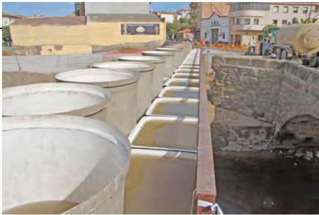
Abans de procedir a l'obertura del nou pas es va fer una prova de carga omplint el pont de dipòsits plens d'aigua.
