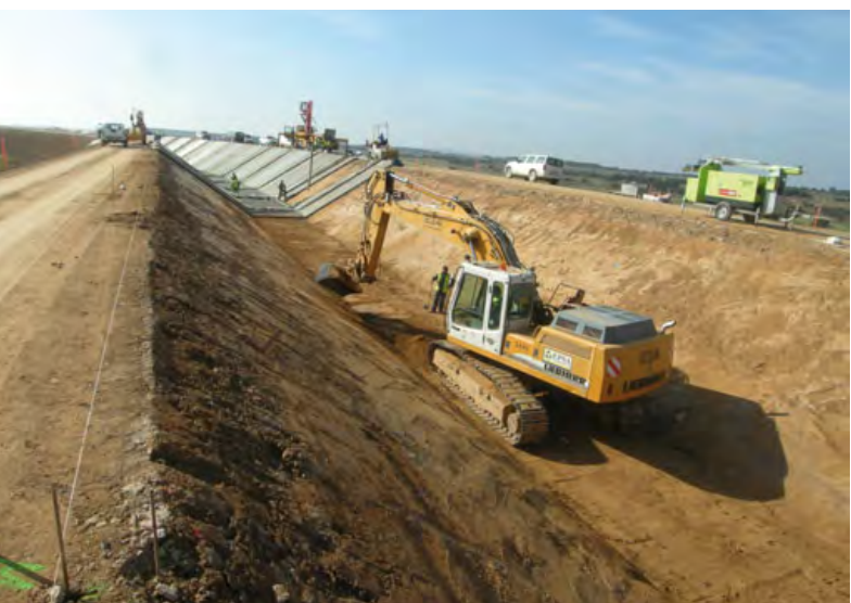
Mentre la Generalitat feia la concentració i la xarxa de reg, l'Estat anava tirant endavant el canal. En la imatge inferior es veu el sistema de construcció utilitzat.
