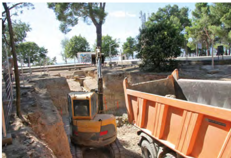
Després de les prospeccions arqueològiques es començà a la construcció de l'accés a la cisterna amb l'extracció de terra amb una retroexcavadora.
