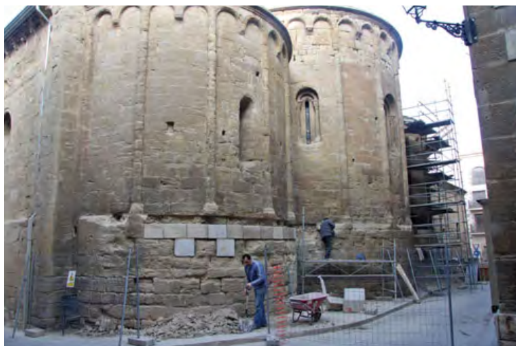
A finals del 2012 comencen els treballs de rehabilitació dels absis de Santa Maria, les obres pendents de la restauració feta uns anys abans. La darrera intervenció va ser durant els anys cinquanta del segle XX quan es van retirar de sobre les torres de defensa que formaven part de l'antiga muralla medieval.
