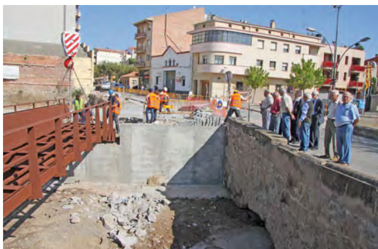
Tant la retirada com la instal·lació van generar força curiositat entre els agramuntins que, en la foto, vigilen la col·locació de la nova passarel·la.
