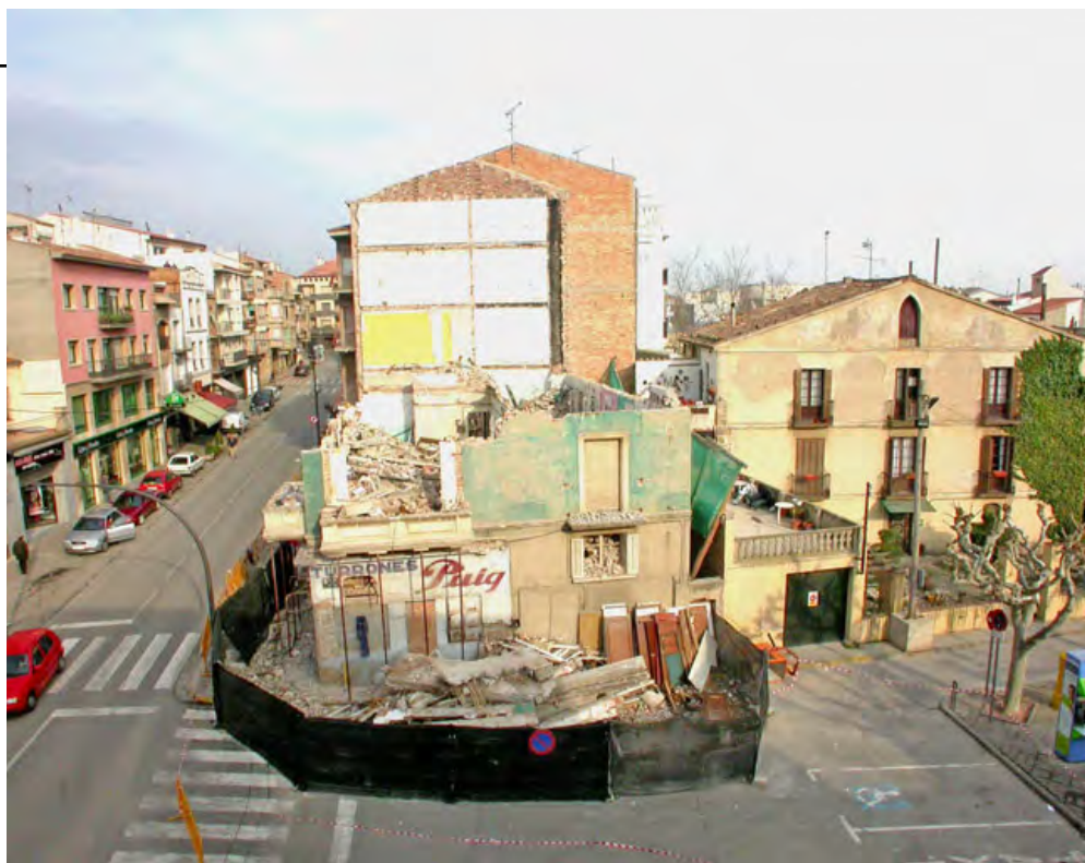
Imatge d'una altra fase de la retirada de l'edifici situat en una transitada cruïlla del centre de la Vila.
