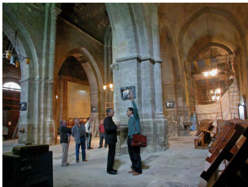
S'inicia la darrera fase de restauració del temple de Santa Maria que afectarà tant el terra, com les voltes i la façana. A la foto, l'inici dels treballs dirigits per Josep Mora i Ramon Maria Hernández.
