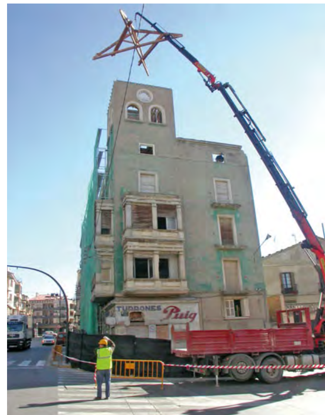
Finalment poden començar les obres d'enderroc de Cal Casalons. En aquell indret de la població ja són mitja dotzena els immobles que han anat a terra en els darrers anys.
