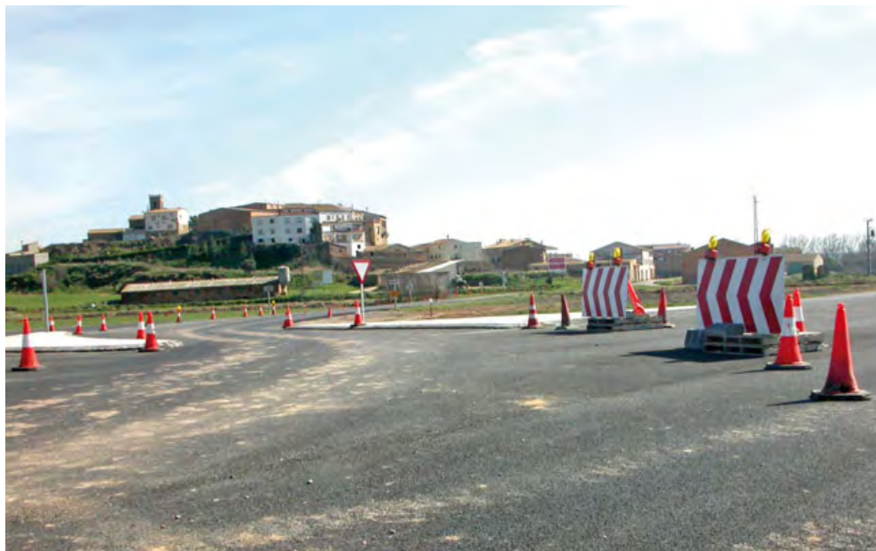
S'obre la variant de la C-14 de Mafet, una obra que quedà pendent quan l'any 1994 es va rehabilitar la carretera fins a Artesa.
