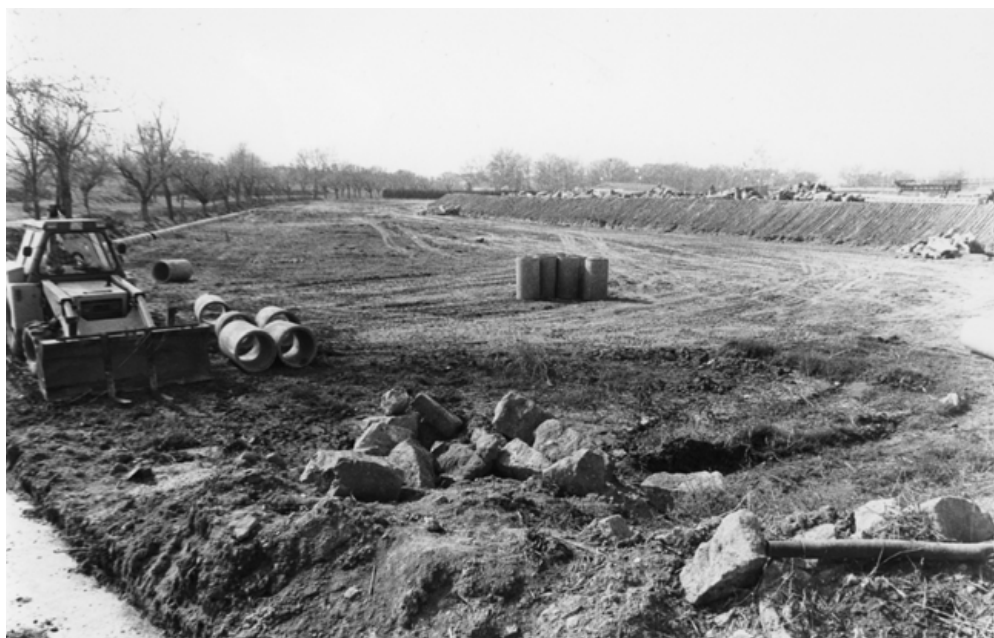
En la foto inferior, es construeix un gran terraplè de protecció per als nous habitatges que deixa una gran zona verda, actualment ocupada pel Parc de Riella.
