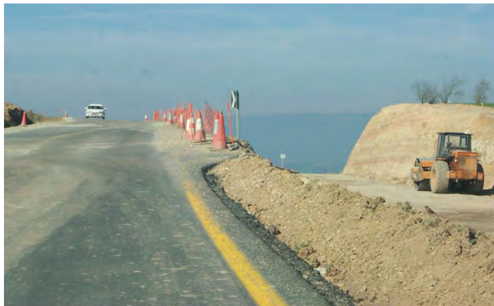
Una de les obres més significatives de la carretera de Tàrraga va ser la supressió del canvi de rasant de la pujada del Campament.
