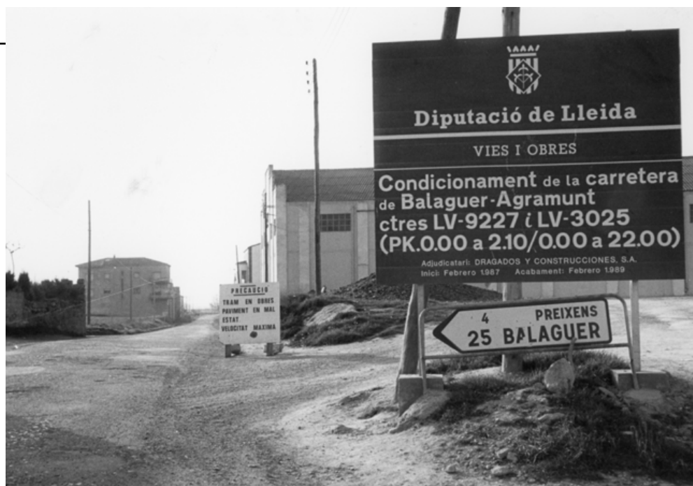
A la segona meitat dels vuitanta la carretera de Balaguer va ser objecte de grans obres de millora amb la construcció de les variants de tots els pobles del recorregut.
