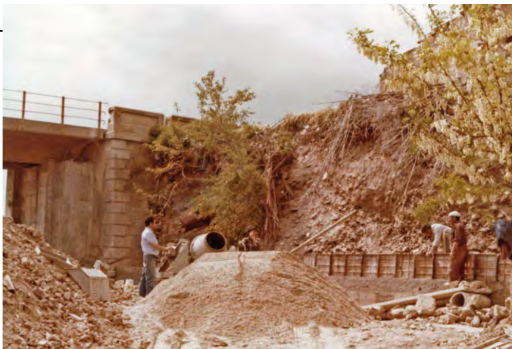
Una de les primeres obres del nou Ajuntament va ser la construcció del mur de contenció al costat del pont de la carretera de Tàrraga.
