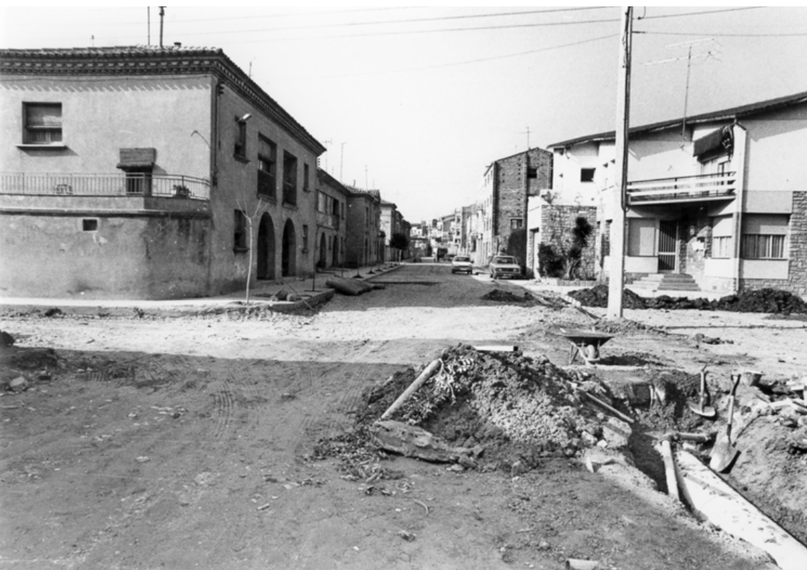
Obres d'urbanització del carrer Verge del Socors. A la dreta la Casa del Metge.
