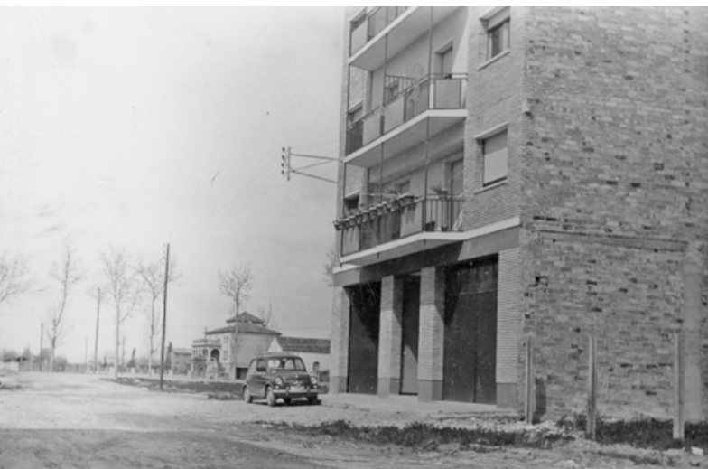
Un dels primers edificis que s'aixeca al carrer Institut. Darrere el que seria carrer de les Planes amb Ca la Trudis al fons.
