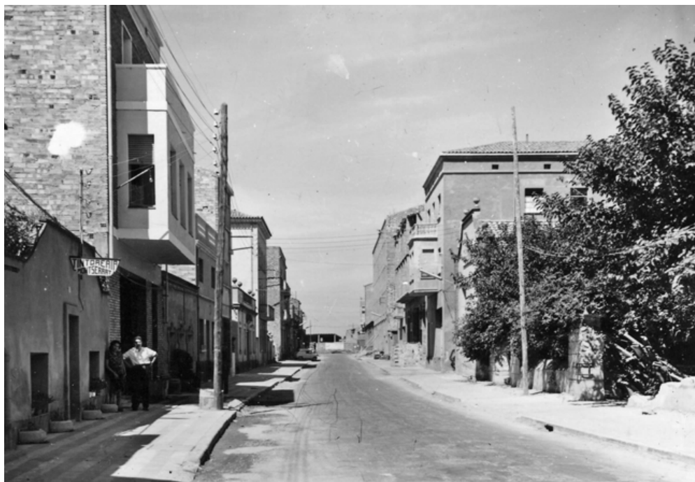
Avinguda Marià Jolonch durant la construcció del bloc d'habitatges de Cal Marina. Darrere els arbres, la fàbrica de Cal Mundí.
