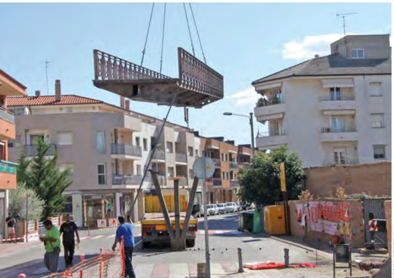
L'operació es repetí amb el segon tram.
