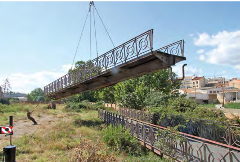
Les dues parts de la passarella van quedar dipositades a l'interior del pati de l'avinguda de Catalunya.
