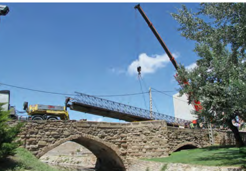
Moment en què la grua eleva el primer tram de la passarella.
