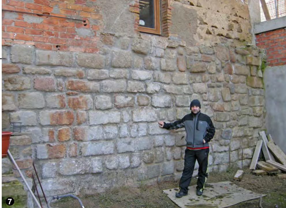
7 Durant les obres de rehabilitació del seu habitatge, Jordi Lluch va consolidar el tram de muralla sobre el que està construït.
