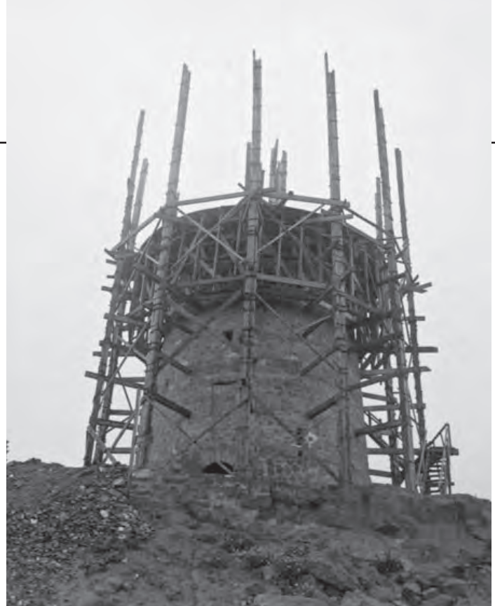
Dipòsit del Castell en plena construcció. Encara ara es detecten els punts per on s'aguantava la bastida.
