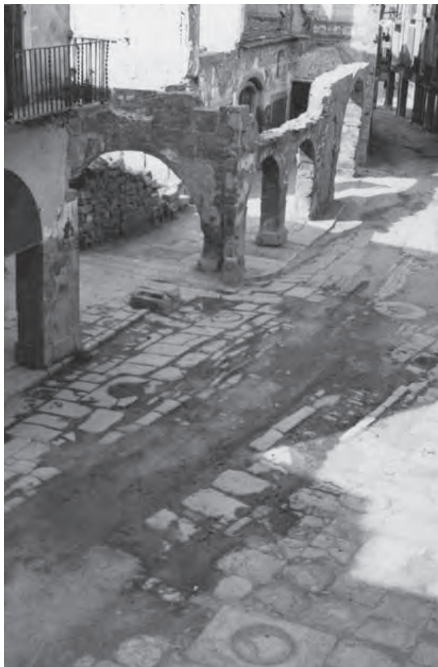
Els grans casalots de cal Viladàs i cal Siscar van ser derruïts com els de la resta al voltant de la plaça.
