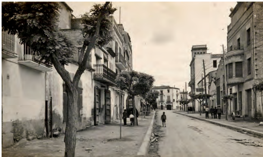
Vista general del Passeig Guimerà als anys 20 totalment urbanitzat.
