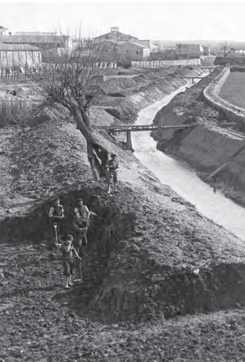
Treballadors de la canalització vistos des del pont de la carretera de Tàrrega.
