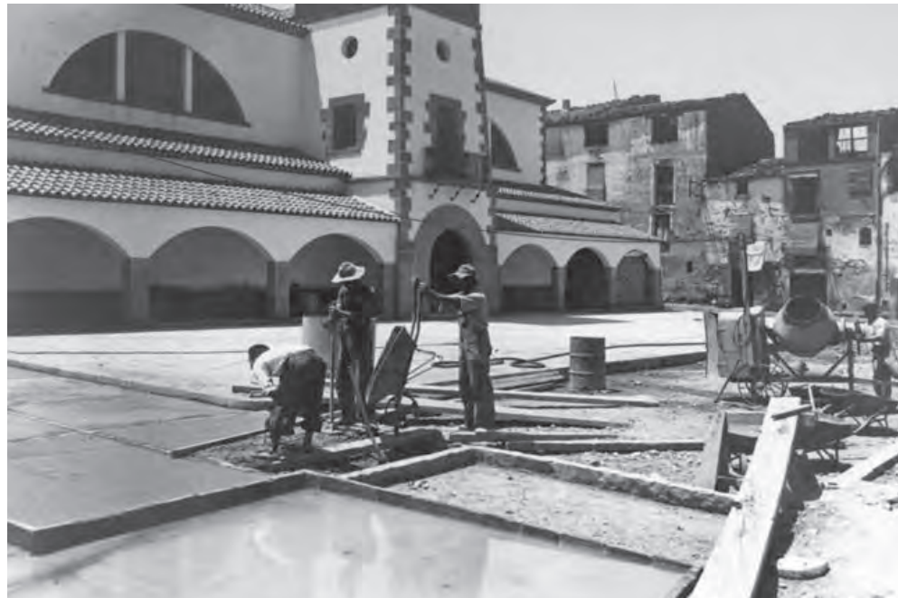
Vista de la plaça del Mercat mentre s'està pavimentant amb les clàssiques "bassetes" que es muntaven perquè el paviment s'amerés d'aigua.
