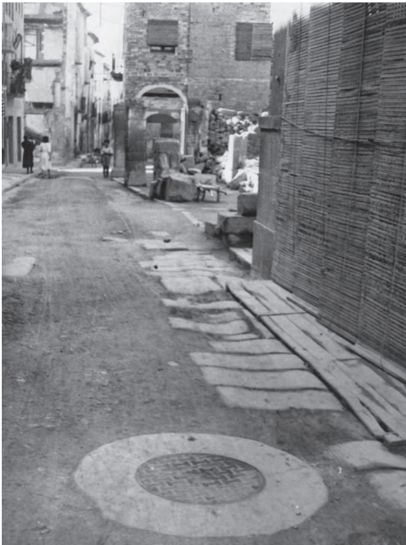
Les destrosses dels bombardejos van afectar edificis, pavimentació i serveis com es veu en el carrer Sió.
