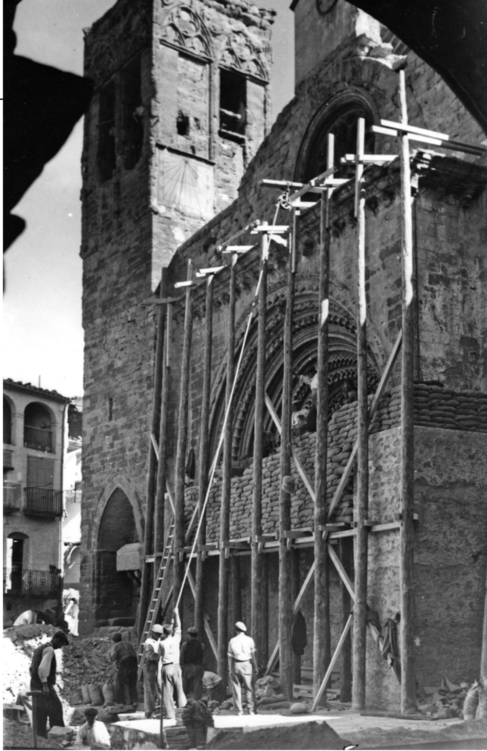
Fotografia emblemàtica dels bombardejos sobre Agramunt. La terra que s'extreu de la construcció de les galeries subterrànies pel refugi de sota Santa Maria s'utilitza per omplir els sacs que han de protegir la portalada romànica del temple.
