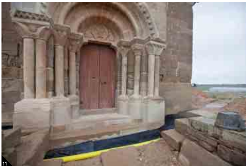
Aspecte de les obres de drenatge davant la portalada.
