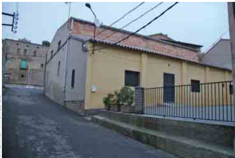
Vista actual del local amb el pati al costat.
