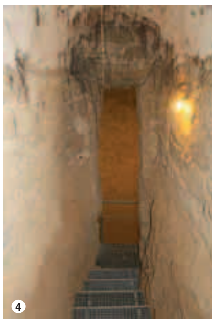
L'obertura d'accés directe a l'interior del pou.
