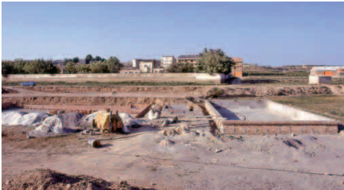
El recinte en plena construcció. A dalt, el vas de la piscina mitjana ja està excavat i revestit. A baix, els vasos de les piscines i el paviment de l'entorn acabats del tot.
