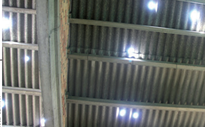
Coberta d'un magatzem ple de gra.
