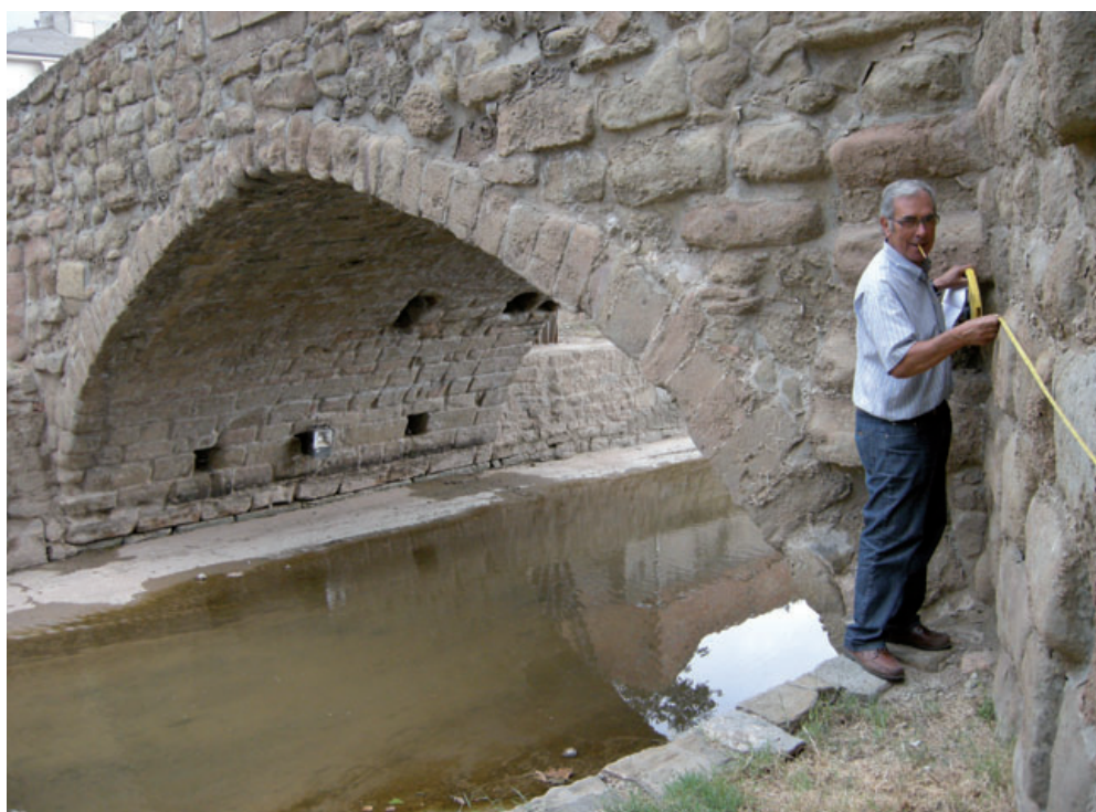
L'autor del reportatge prenent mesures a l'estructura del viaducte.
