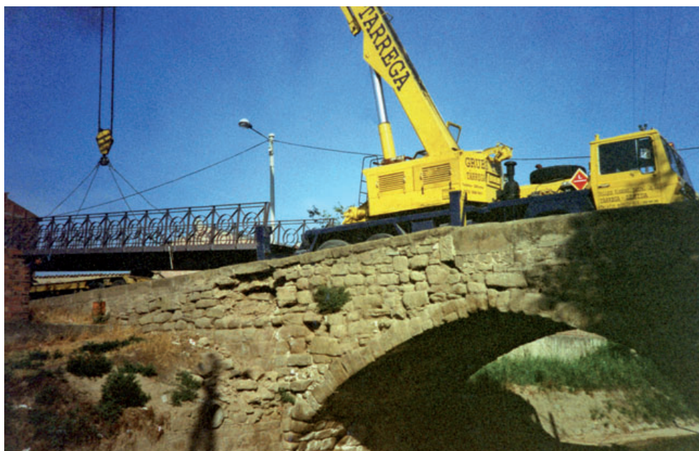
La instal·lació metàl·lica del pont va aixecar molta expectació (foto superior). Un camió grua, treballant al bell mig del pont, va causar lleus desperfectes a la paret.
