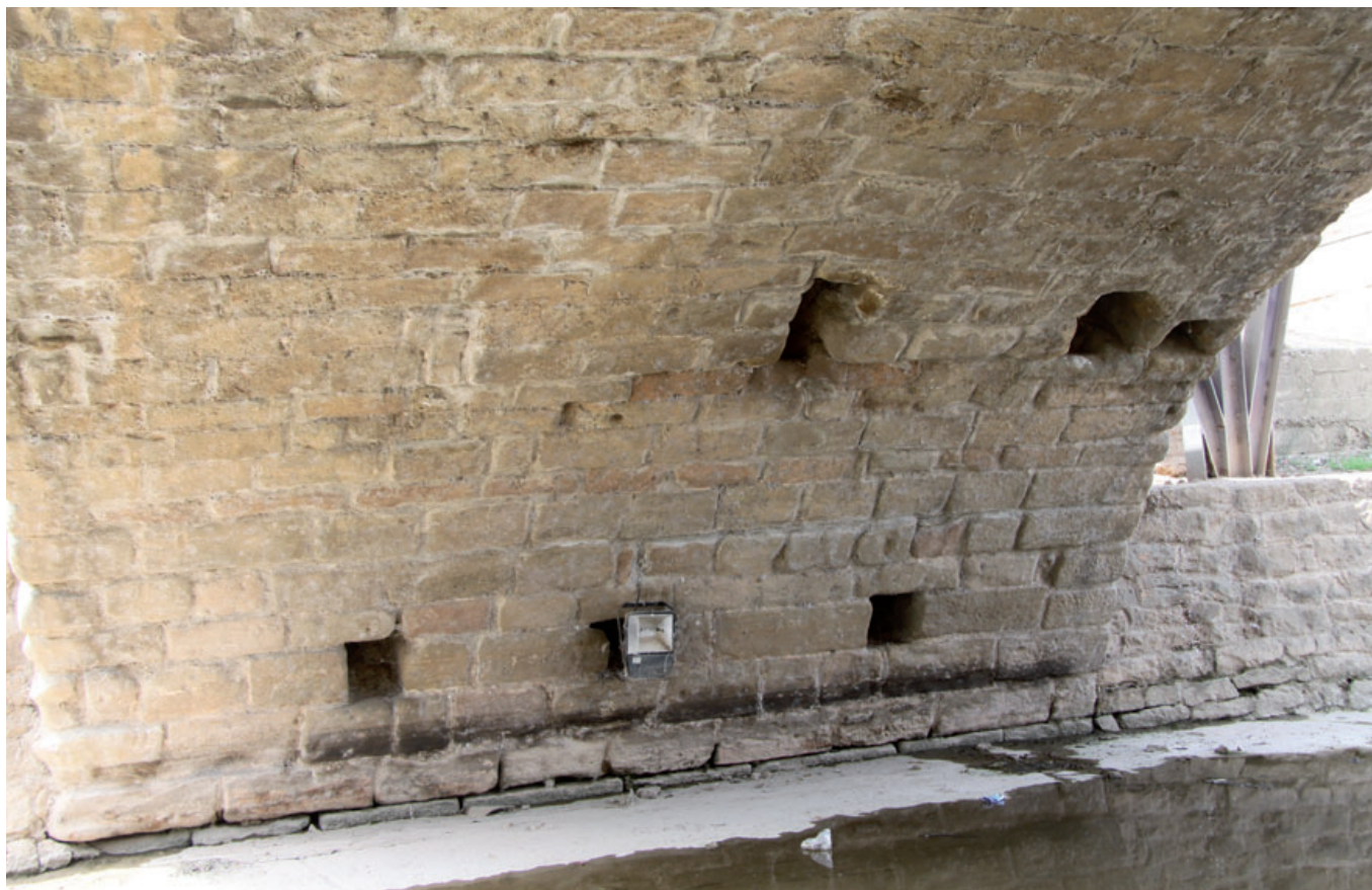
Intradós o volta del pont amb els forats que es van utilitzar per fixar les bastides durant la seva construcció.
