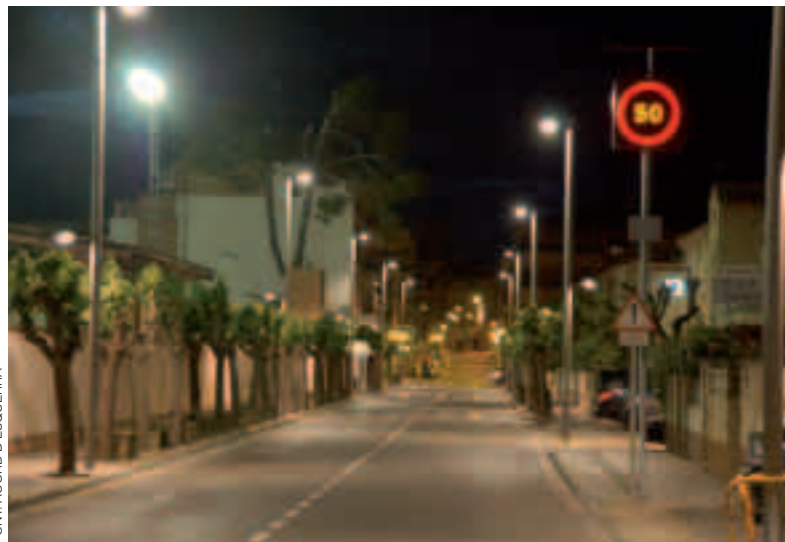
Instal·lació d'enllumenat eficient a la Ctra. de Cervera.
