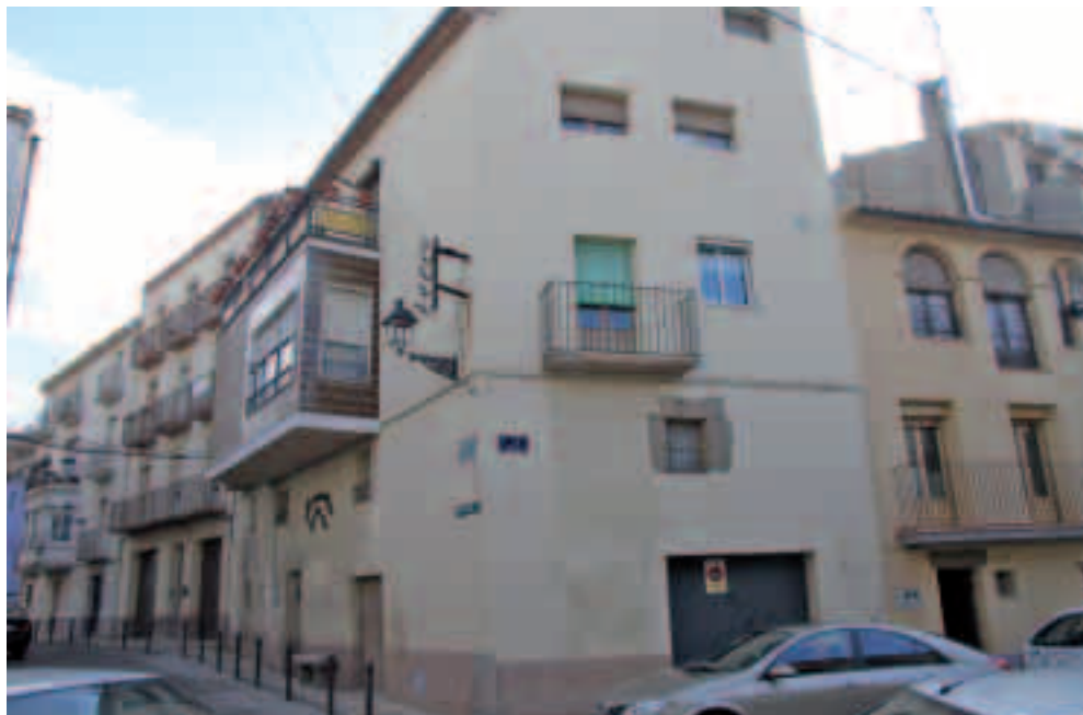
La Paeria de l'època es va vendre aquests dos patis de la cruïlla de la plaça l'Amball amb Estudis Vells, per poder continuar les obres de construcció de l'edifici municipal.
