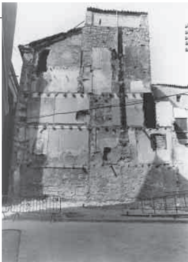
El pati resultant sobre el que es va construir el nou edifici municipal.
